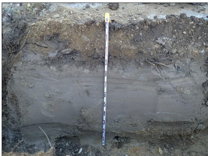
Tien kohdalle kaivettua kaapeliojaa. Reilun parikymmen senttisen moreenikerroksen alla tällä kohtaa kaivantoa maalajina oli savi. Pohjoiseen.
